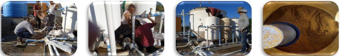
**Figura 68** Cambio de cargas en filtros y lavado de aljibe en planta potabilizadora
