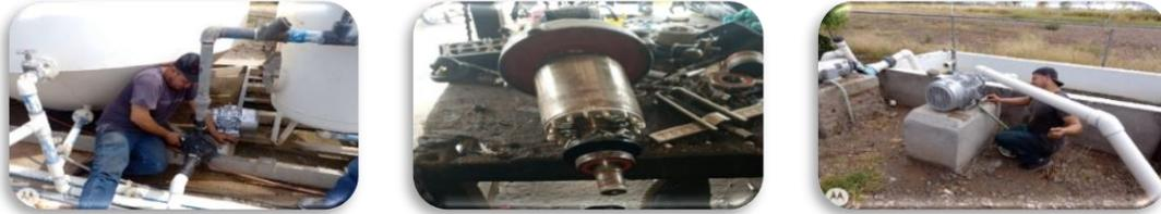
**Figura 67** Mantenimiento preventivo a bombas de suministro de agua de edificios y áreas verdes
